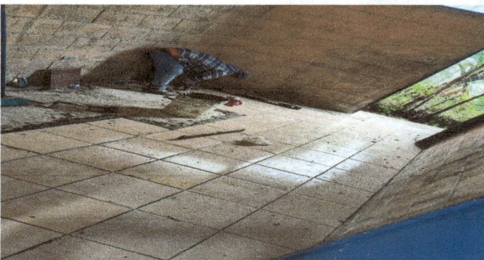
Foto 6: Modulo 1 Sustitución de piso rústico por piso cerámico en direccion.
