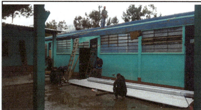
Foto 3: Modulo 2 (corredor) Desmontaje de laminas y viga de madera en el corredor
