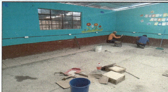
Foto 7: Módulo 2. Colocacion de piso ceramico en el aula 6 de computacion.
