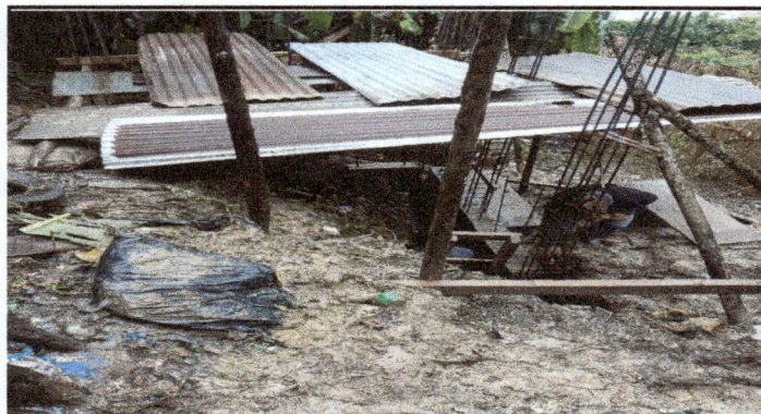
Foto 9: Trabajo de Rehabilitación de muro perimetral al lado izquierdo del porton de la entrada.
