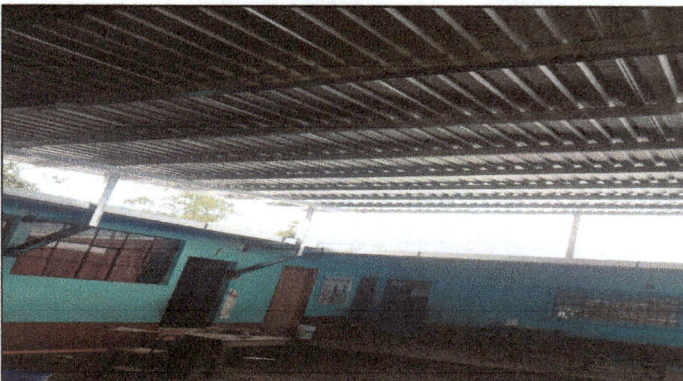
Foto 4: Modulo 2 (corredor) Trabajo de sustitucion de lámina por lámina troquelada maxalum calibre 26 original.
