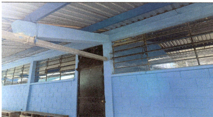
Foto 10: Aplicación de pintura en paredes exteriores del modulo 1
