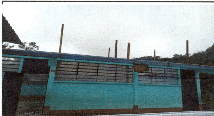
Foto1: Modulo 1. Desmontaje de lámina de dos aulas y la direccion.
