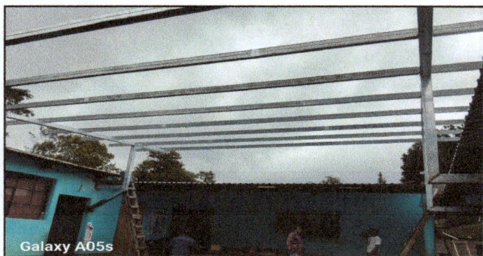
Foto 5: Modulo 2 (corredor) cambio de columna de madera a metal para soporte de estructura del techo.
