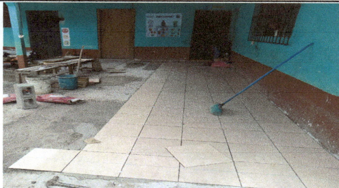
Foto 8: colocacion de piso cerámico en el corredor del aula 6 de computación
