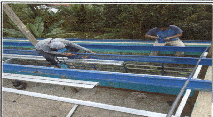
Foto 2: modulo 1. Trabajo de mantenimiento de estructura de metal (lijado, cepillado, limpieza, aplicación de anticorrosivo mas pintura de esmalte).
